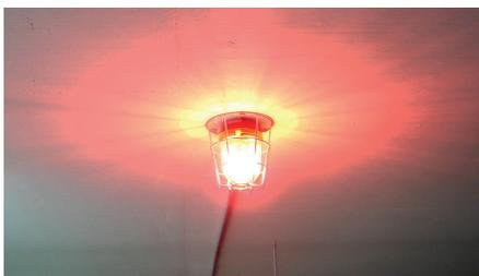
Die Blitzleuchte signalisiert dass die Anlage in Betrieb ist und gibt somit dem Nutzer sowohl den Leuten in der Nähe der Anlage mehrere Sicherheit beim Benutzen. Eine Blitzleuchte kann bis für 2 Anlagen benutzt werden.
