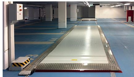
Der Antrieb muss in der Mitte des gesamten Fahrwegs platziert werden, vorzugsweise an einer Säule/vor Gebäudestütze.
